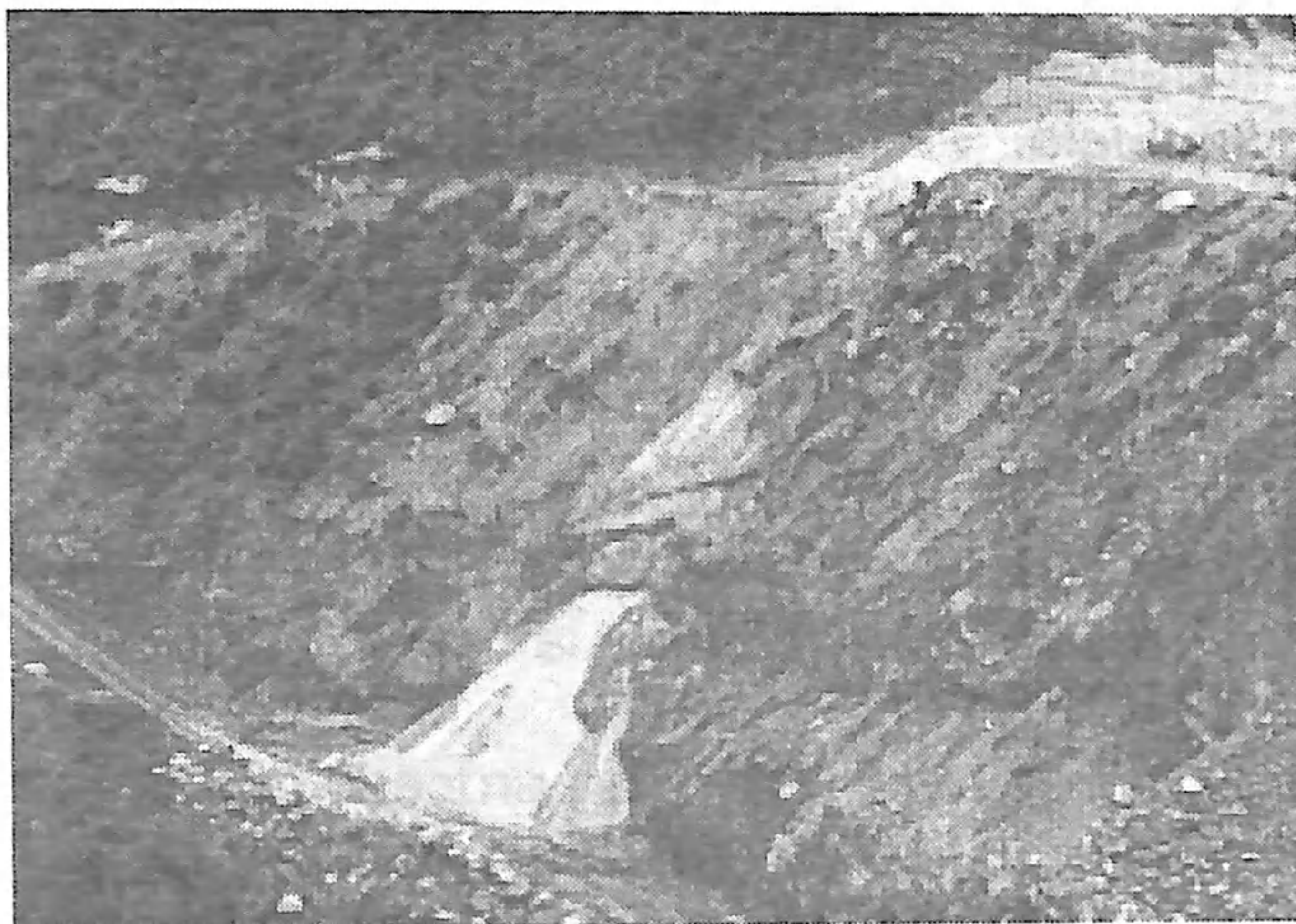
Deslizamiento de mina afectando a comunidad Xecaracoj
